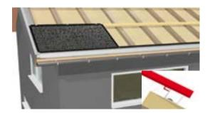
À présent, le montage commence : Tout d'abord, l'abergement de couvreur-zingueur inférieur est fixé. Après cela, le rail de base est monté et vissé sur le lattage transversal.
