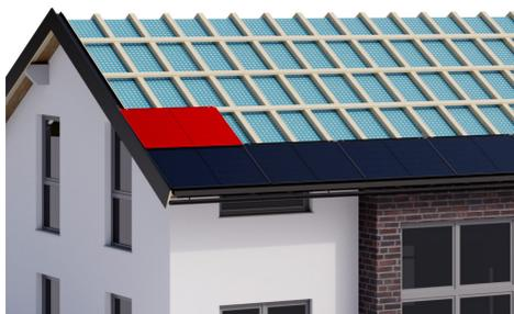
Commencez le montage du second rang là encore du côté gauche. Pour ce faire, faites coulisser le panneau dans l'insertion du profilé de raccordement du toit du panneau situé en dessous.
