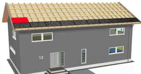
Commencez le montage du second rang là encore du côté gauche. Pour ce faire, faites coulisser le panneau dans l'insertion du profilé de raccordement du toit du panneau situé en dessous.
