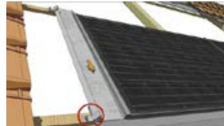
Fixieren Sie anschliessend das Blech mit dem Befestigungs-Haken auf der Lattung.
