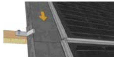
Installieren Sie das Anschlussblech der darüber liegenden Modulreihe auf dieselbe Art und Weise. Schieben Sie das Anschlussblech so in das Darunterliegende, dass die Überlappung mindestens 8 cm beträgt.
